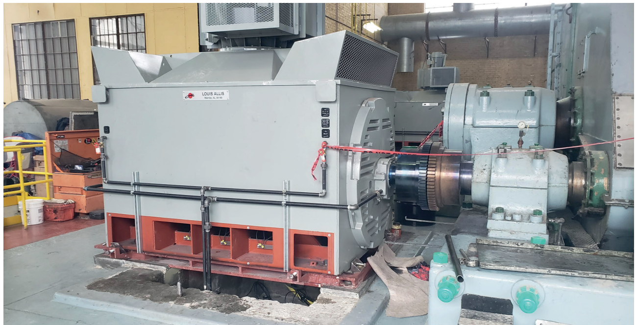
Abb. 6: Der neue Wechselstrommotor für die Seilfahrt-Fördermaschine.
